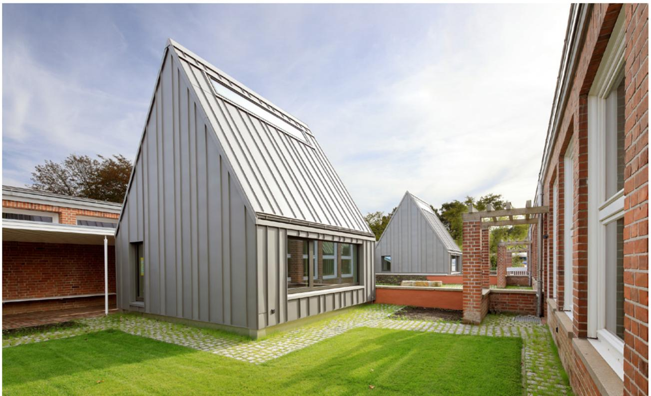
Der serielle Charakter der ergänzten Gebäude, die in einer ‚Field Factory‘ vor Ort vorgefertigt wurden, und die kurzen Wege zum Einheben an den endgültigen Standort bedingten die knappe Bauzeit. Die in sich schlüssigen Ergänzungsbauten verfügen nach außen aufgrund der gewählten Dacheindeckung und Fassadenbekleidung aus Zinkblech über einen konsequent ausgebildeten Witterungsschutz. Innen farblich gefasste Oberflächen zeigen, dass Holz und Farbe ganz und gar keinen Widerspruch darstellen.
